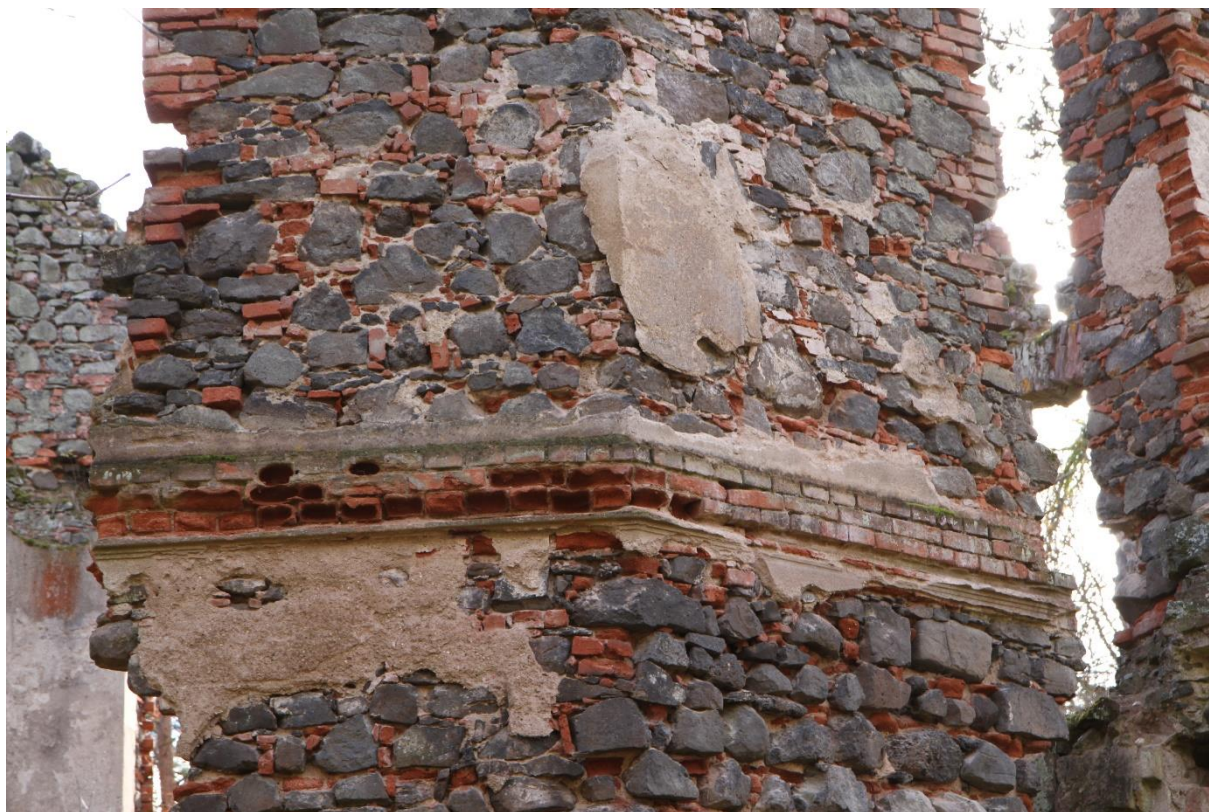
Detail fragmentů omítek a kordonové římsy
