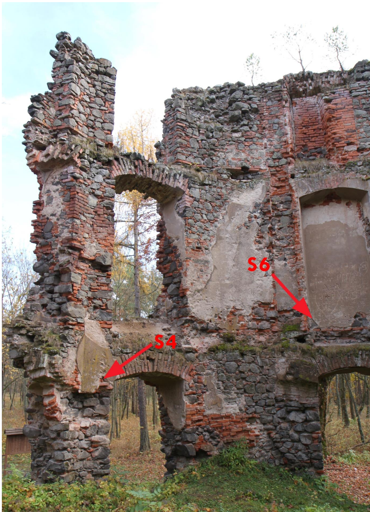
Umístění sond v interiéru
