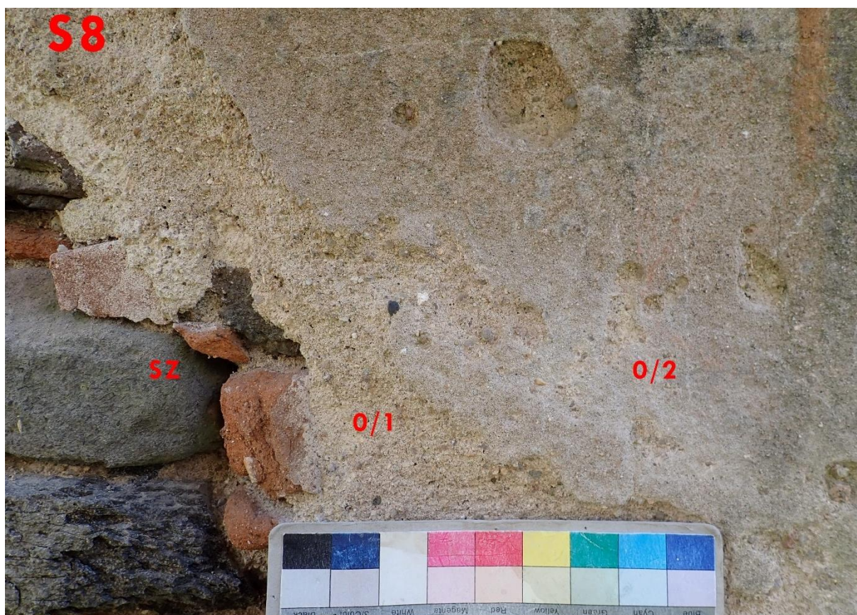
Sonda S8 v interiéru: SZ-smíšené zdivo, 0/1-spodní vrstva omítky, 0/2-vrchní zatažená vrstva omítky
