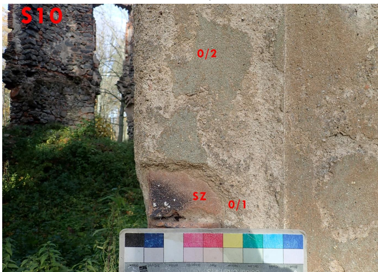
Sonda S10 na fasádě: SZ-smíšené zdivo, 0/1-spodní vrstva omítky, 0/2-vrchní zatažená vrstva omítky
