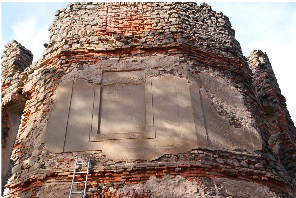
Část dochované omítky s čitelný, průběhem lizénových rámců a zpracováním šambrány slepého okna
