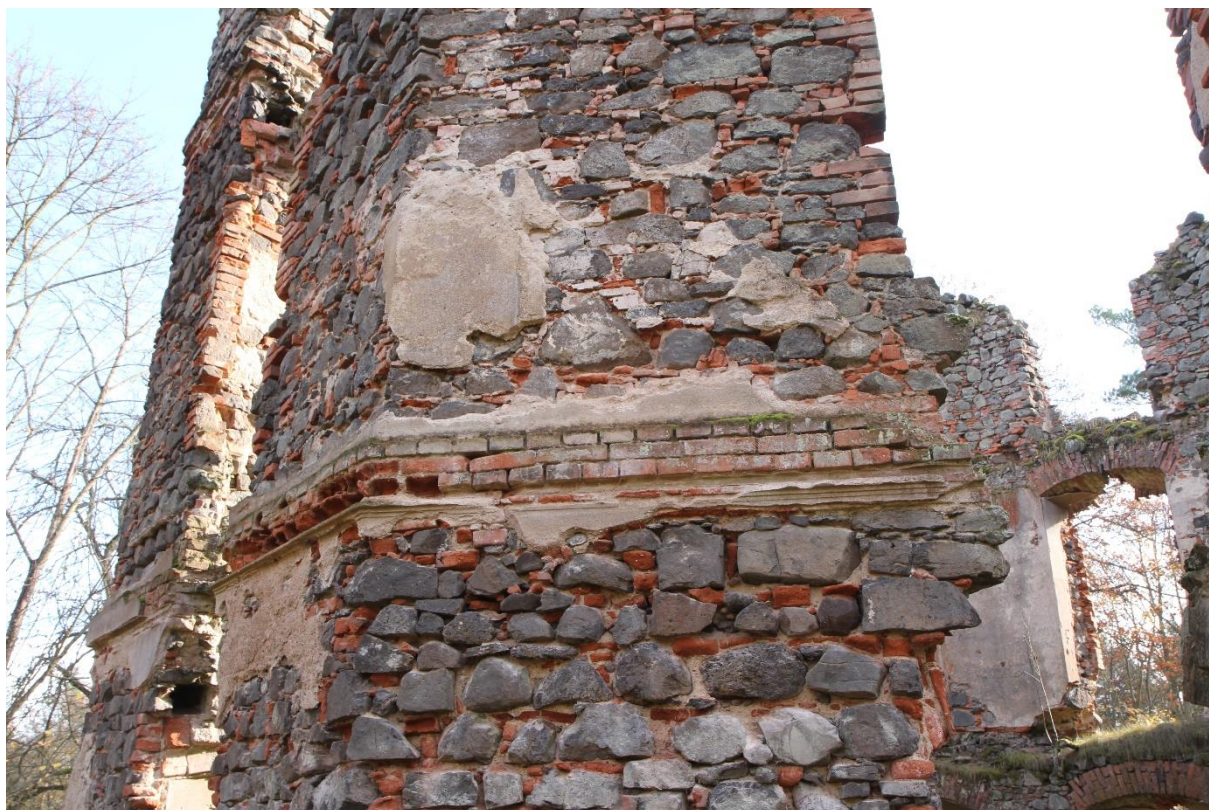
Detail fragmentů omítek a kordonové římsy mezi přízemím a prvním patrem
