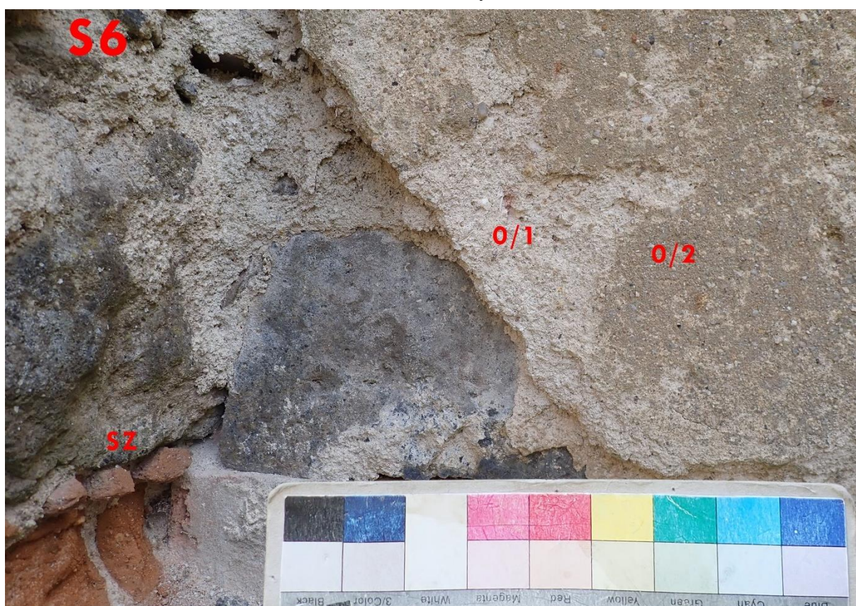
Sonda S6 v interiéru: SZ-smíšené zdivo, 0/1-spodní vrstva omítky, 0/2-vrchní zatažená vrstva omítky
