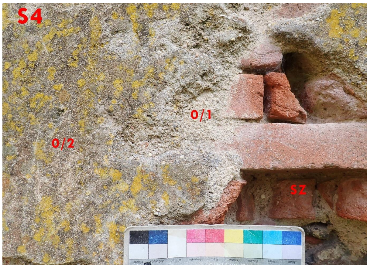
Sonda S4 v interiéru: SZ-smíšené zdivo, 0/1-spodní vrstva omítky, 0/2-vrchní zatažená vrstva omítky
